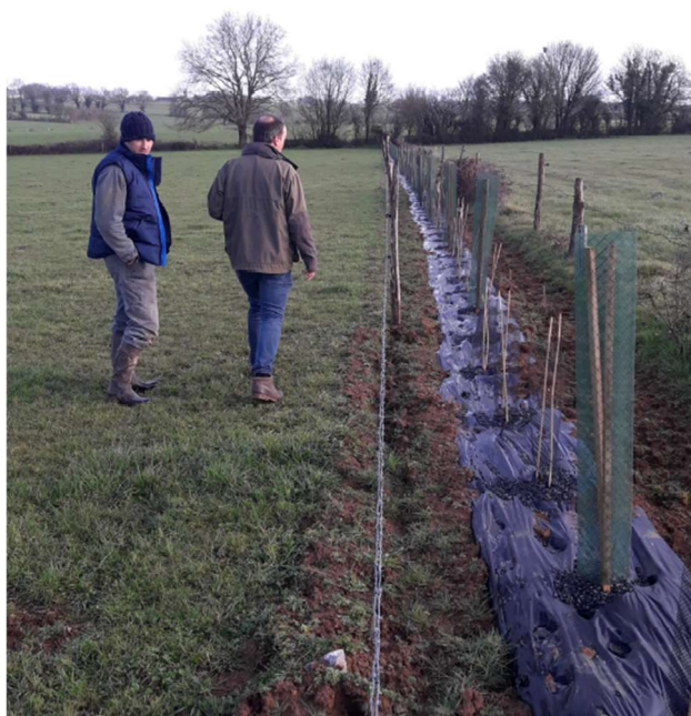
Photographie : Réception des travaux 2020
